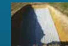
POSE DU GEOTEXTILE
